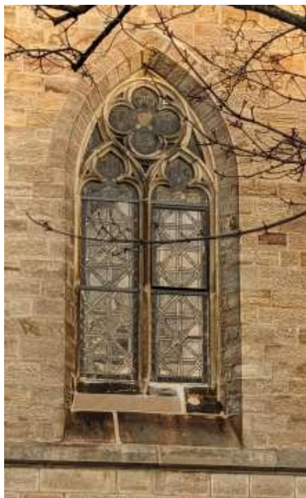
.. und nach der Reparatur. Fotos: Dr. Reiche
